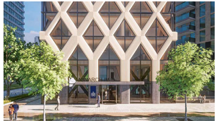
De vloerbalken zijn vanaf de straat aan het zicht onttrokken, waardoor je geen driehoeken maar een patroon van ruiten ziet
