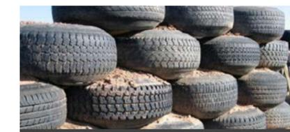
Les colonnes avec pneus peuvent résister à une pression 50% plus élevée que celles sans pneus.
