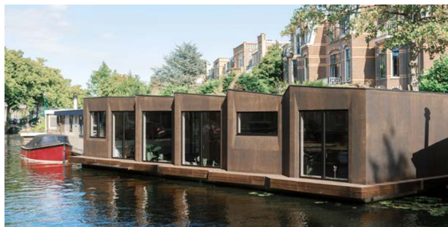
The Float: een drijvende woning met CLT structuur en gevel uit kurk.
