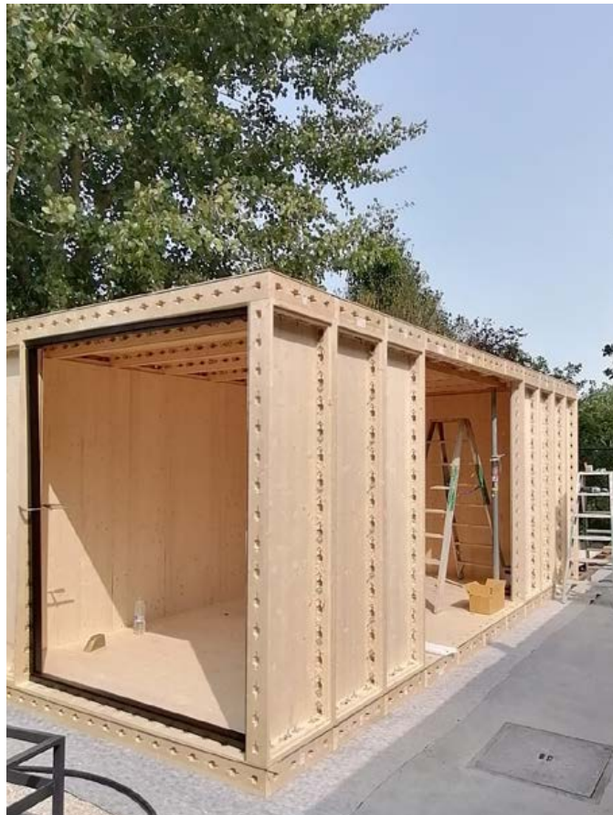
Een eerste testopstelling: de houten units waaruit dit tuinhuis is opgebouwd, werden door robots gemaakt.
