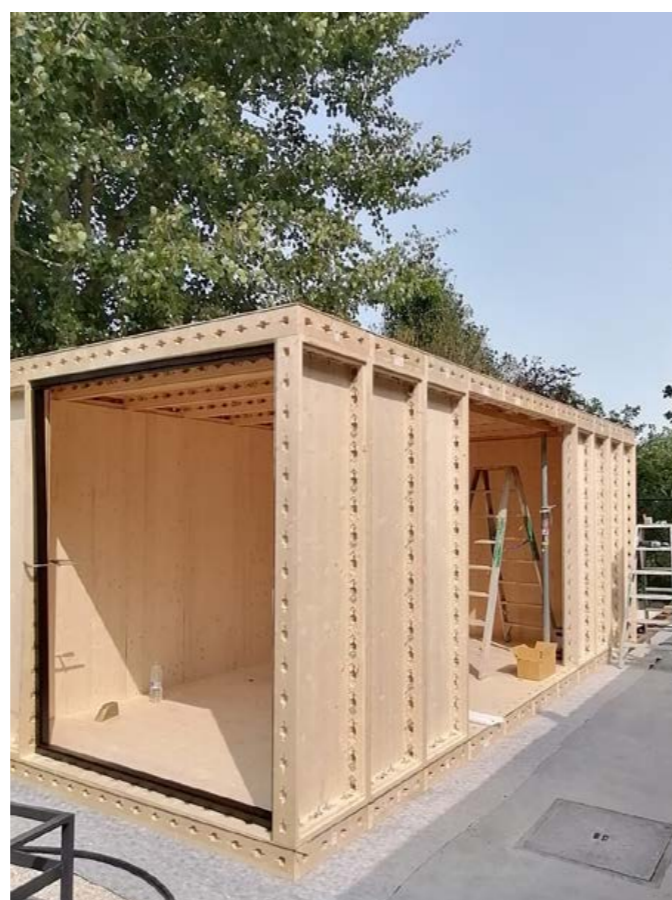
Un premier chantier pilote: les unités en bois qui composent cet abri de jardin ont été fabriquées par des robots.
