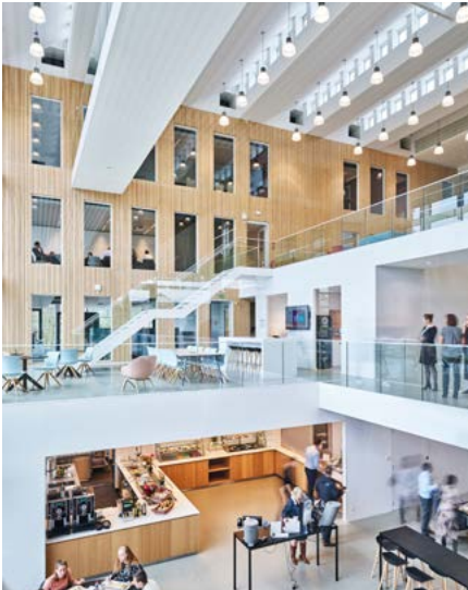
Vandemoortele Food Experience Center, flexibel en modulaair gebouw ontworpen in samenwerking met Thomas Rau architects. Slimme integratie van technieken, modulaire, demontabele gevel
