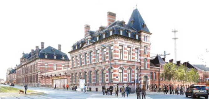
Usquare Brussel, voor VK architects+engineers een toonvoorbeeld van succesvol circulair bouwen
