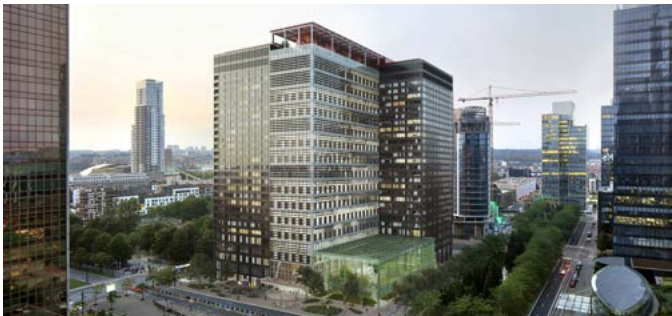
ZIN, 30 materialen in het gebouw zijn C2C-gecertificeerd, waaronder de nieuwe betonnen vloeren, glazen en aluminium gevel, binnenmuren en vloeren
