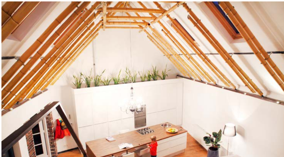
Svens eigen woning kreeg een bamboe dakgebinte
